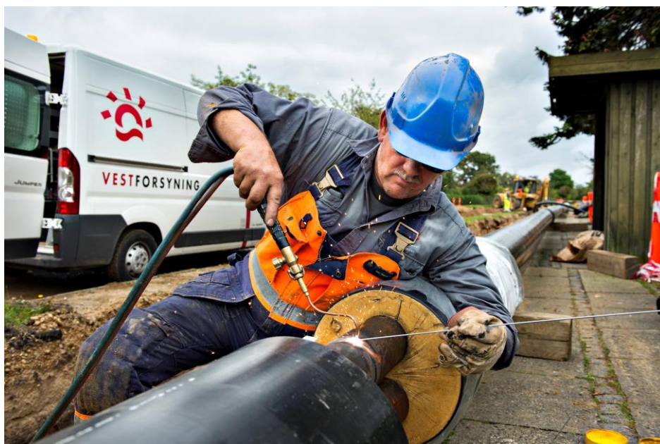
Udbygning af fjernvarmenettet i Vestjylland. Foto Jens Bach.
