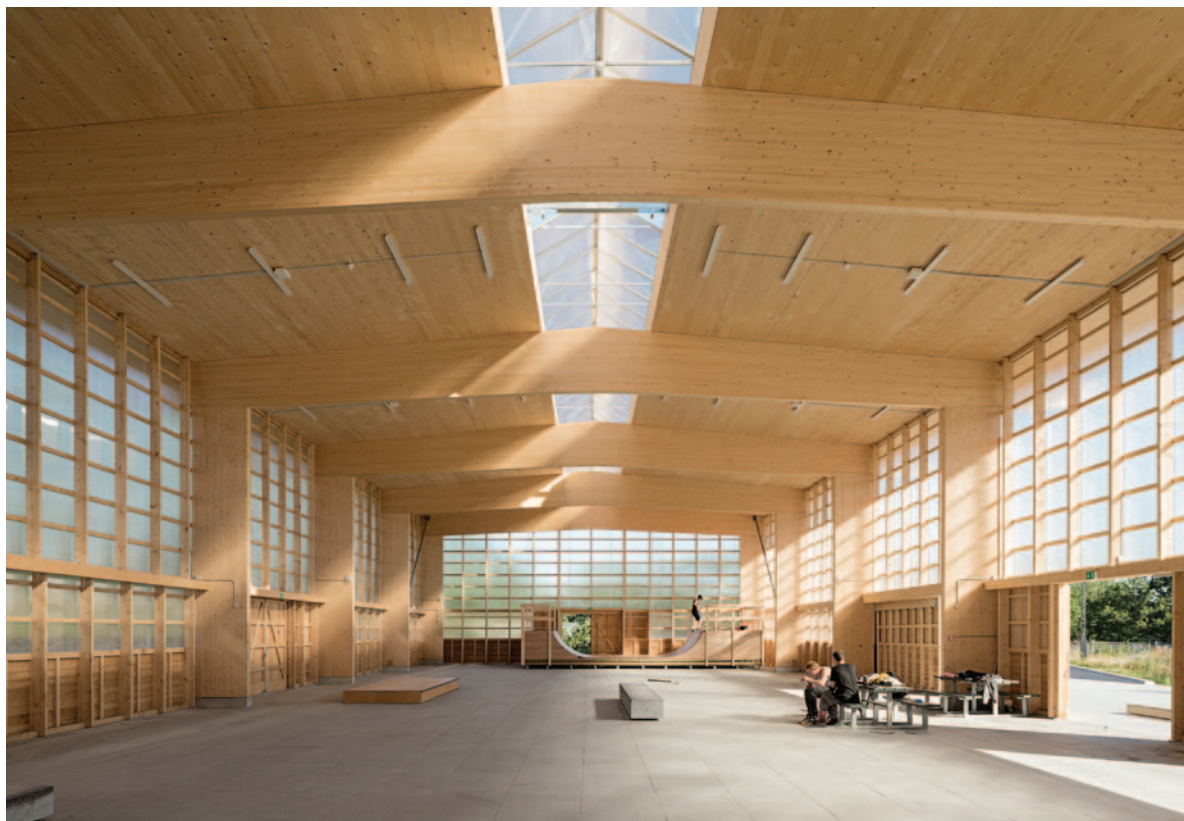
Lethal i Gentofte (Tegnestuen Vandkunsten): Den CO 2 -neutrale lethal er udelukkende bygget af miljøvenlige materialer. Den drives og vedligeholdes af brugerne og koster kun en femtedel af en traditionel indendørs idrætshal af samme størrelse, når man inkluderer drift og vedligehold. Foto: Mads Frederik
